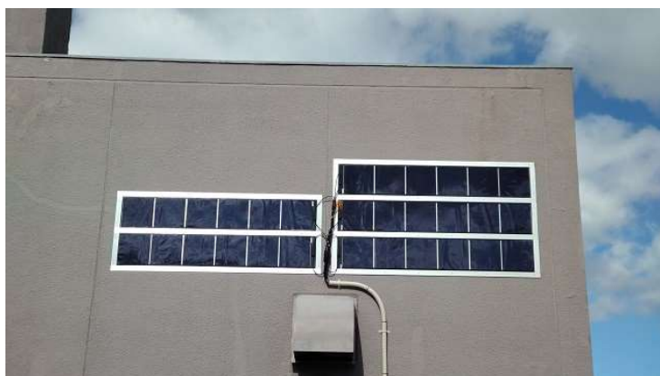
研究開発センター構内の建物壁面に設置したフィルム型ペロブスカイト太陽電池
